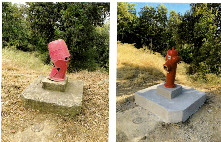
Photos 15 et 16 : borne incendie avant et après remplacement
