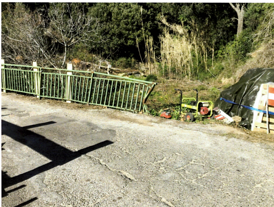
Photo 13 : "pont d'Anton-Marcu" avant rénovation
