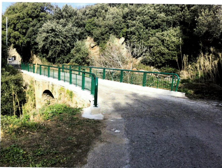
Photo 14 : "pont d'Anton-Marcu" après rénovation
